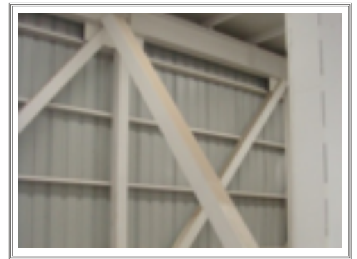
b) Sección formada con dos ángulos
