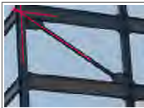
a) Marco con contravientos concéntrico
