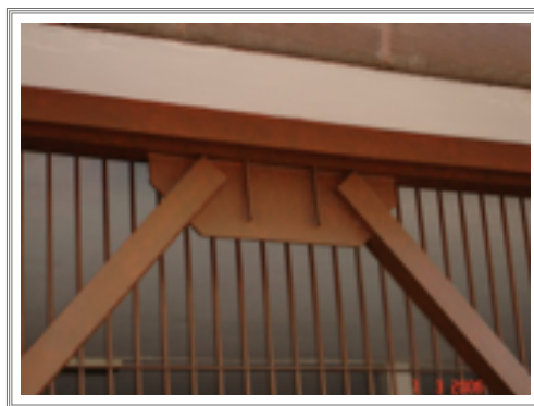
c) Sección formada por placas
