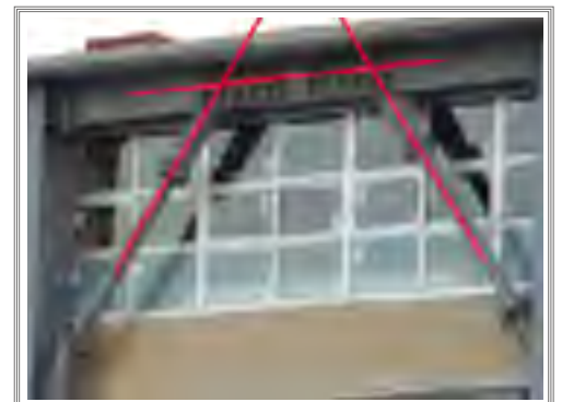
b) Marco con contravientos excéntricos
