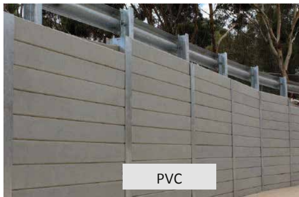
Fig. 3 Tablones de concreto prefabricado, madera y PVC en muros Berlín
