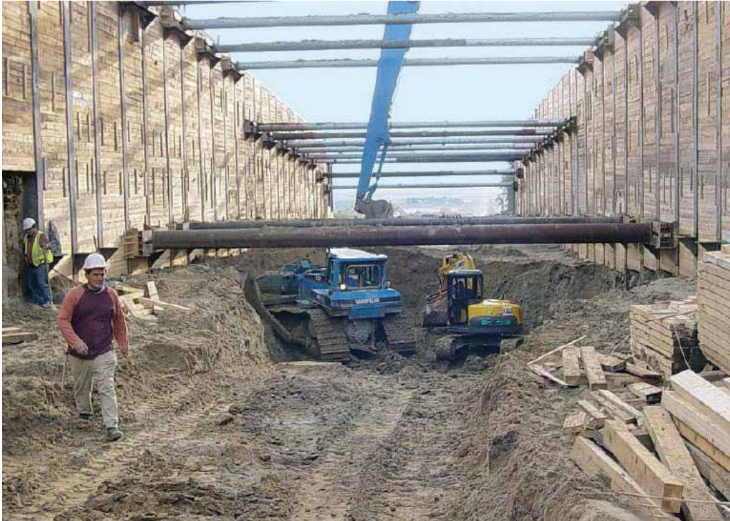
Fig. 11 Muro Berlín apuntalado en una nueva fase de excavación parcial (Yepes Piqueras, 2015)
