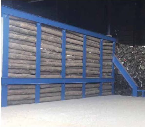
Fig. 25 Muro Berlín para contención de chatarra en los patios de Gerdau-Corsa (México)
