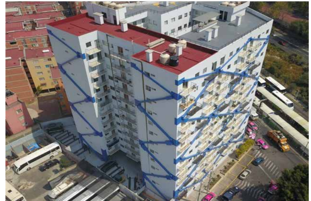
Figura 9. Uso de disipadores tipo Dampo 1505
